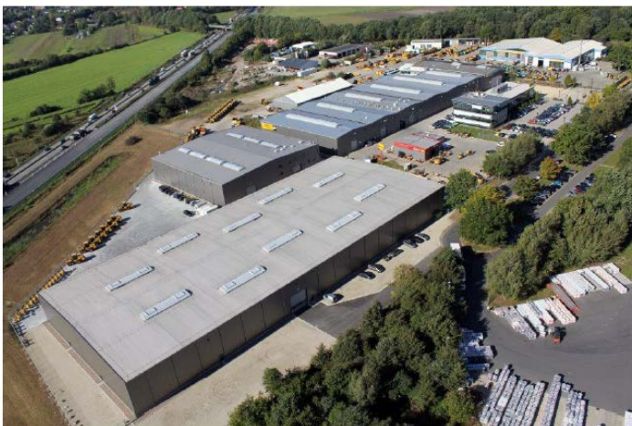
BU2: Zeppelin Power Systems: Engineering, Fertigung und Ausrüstung am Standort Achim
