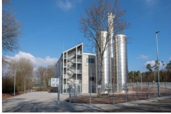
Außenansicht des Blockheizkraftwerks in Ramstein (© Pfalzwerke)
